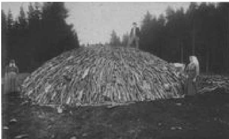
Obr. 4 Milier na výrobu dreveného uhlia predtým, ako sa pokryje hlinou a začne sa vypaľovať (fotografia približne z roku 1890).
