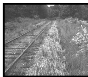
Obrázok 46- Okolie koľajníc tesne po ošetrení horúcou parou
